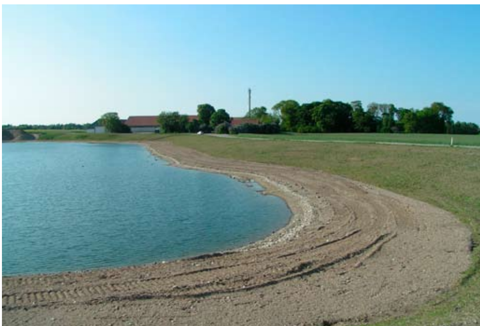
Eksempel på færdiggravede og efterbehandlede skrånninger langs Kaldredvej.
