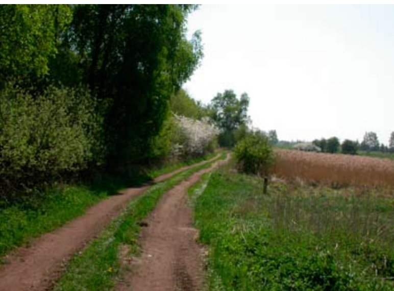
Foto 4. Passage af § 3-områder på sydsiden af Bregninge Å, eksisterende kørespor. Vejen må forventes udvidet ca. 2 m i bredden. Da vejen kun indrettes som ensporet, bør der af hensyn til oversigtsforhold ske rydning af mosepartierne på de to hjørner, som passerer.
