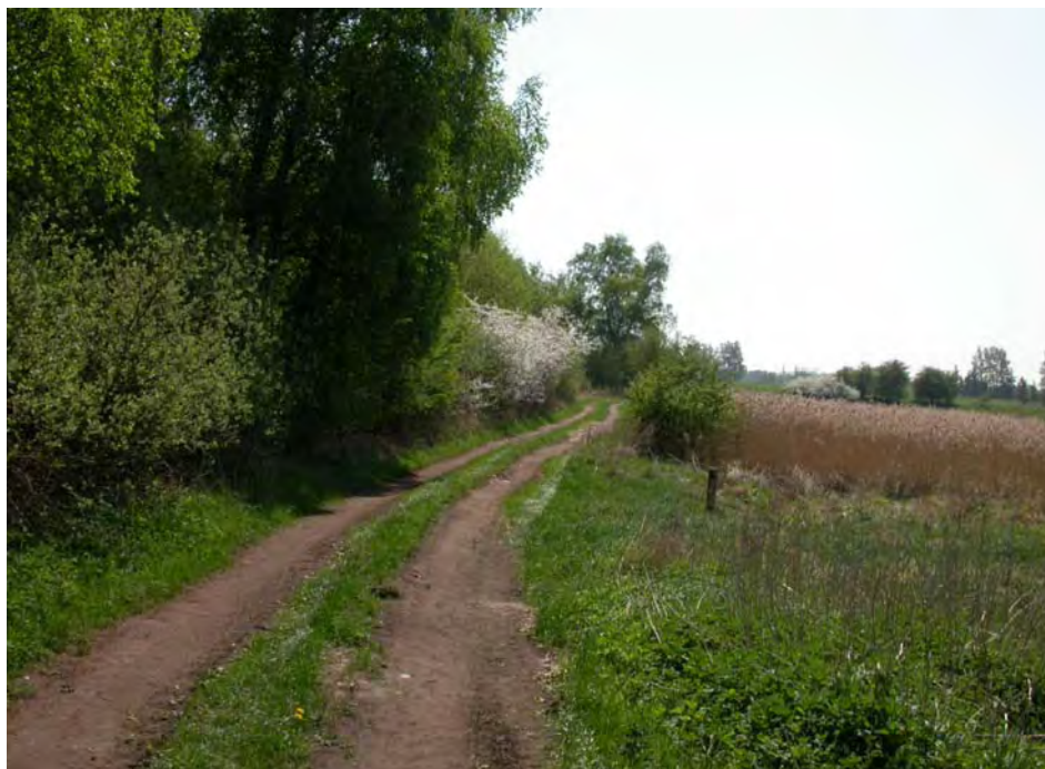
Foto 6. Som den eneste del af strækningen, hvor kørevejen medfører forstærkning/udbygning som medfører et mindre indgreb i §3-områder. Vejforløbet kræver en ca. 1½ meter udvidelse og forstærkning af eksisterende markvej. Da vejen foreslås etableret som ensporet kørevej, skal krydsning af køretøjerne fungere via vigepladser. For at undgå etablering af en vigeplads på strækningen, som ses af ovenstående foto og foto nr. 10 foreslås af hensyn til oversigtsforhold at krattet på venstre hånd ryddes.
