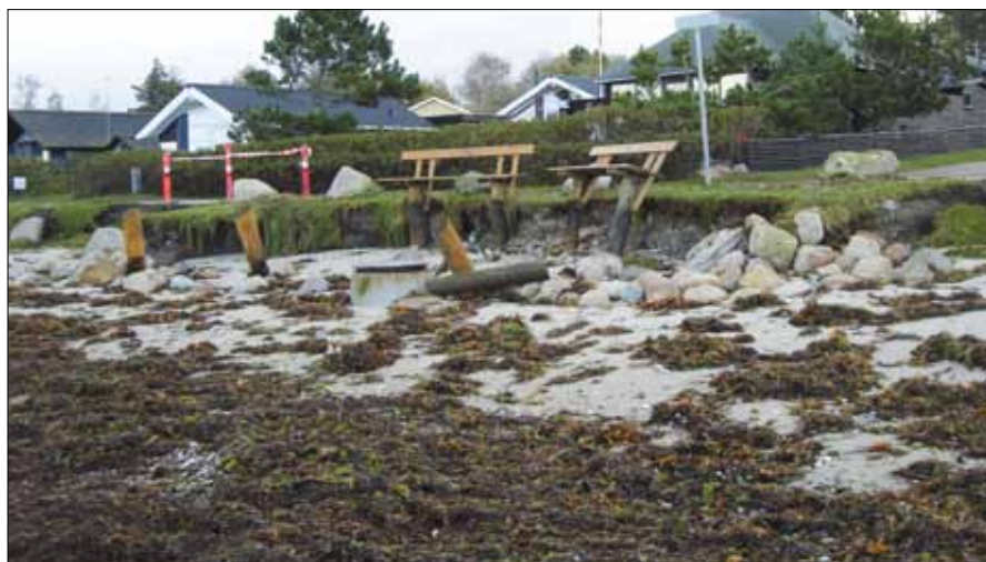
Skader på kyststrækning ved Havnsø. Foto: Rikke Engelhardt Kofoed.
