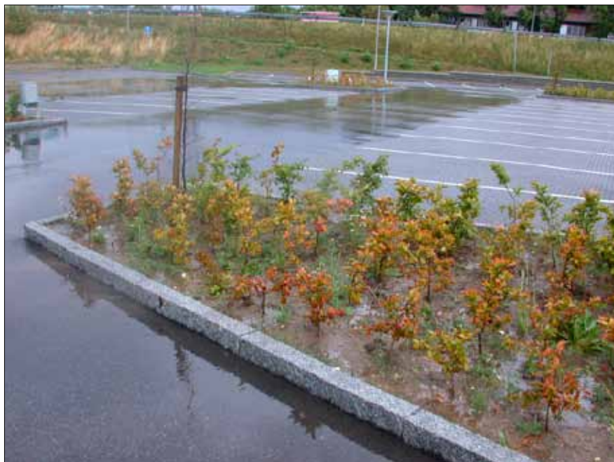
Store asfalterede og flisebelagte arealer, uden mulighed for nedsivning, giver anledning til oversvømmelser.
