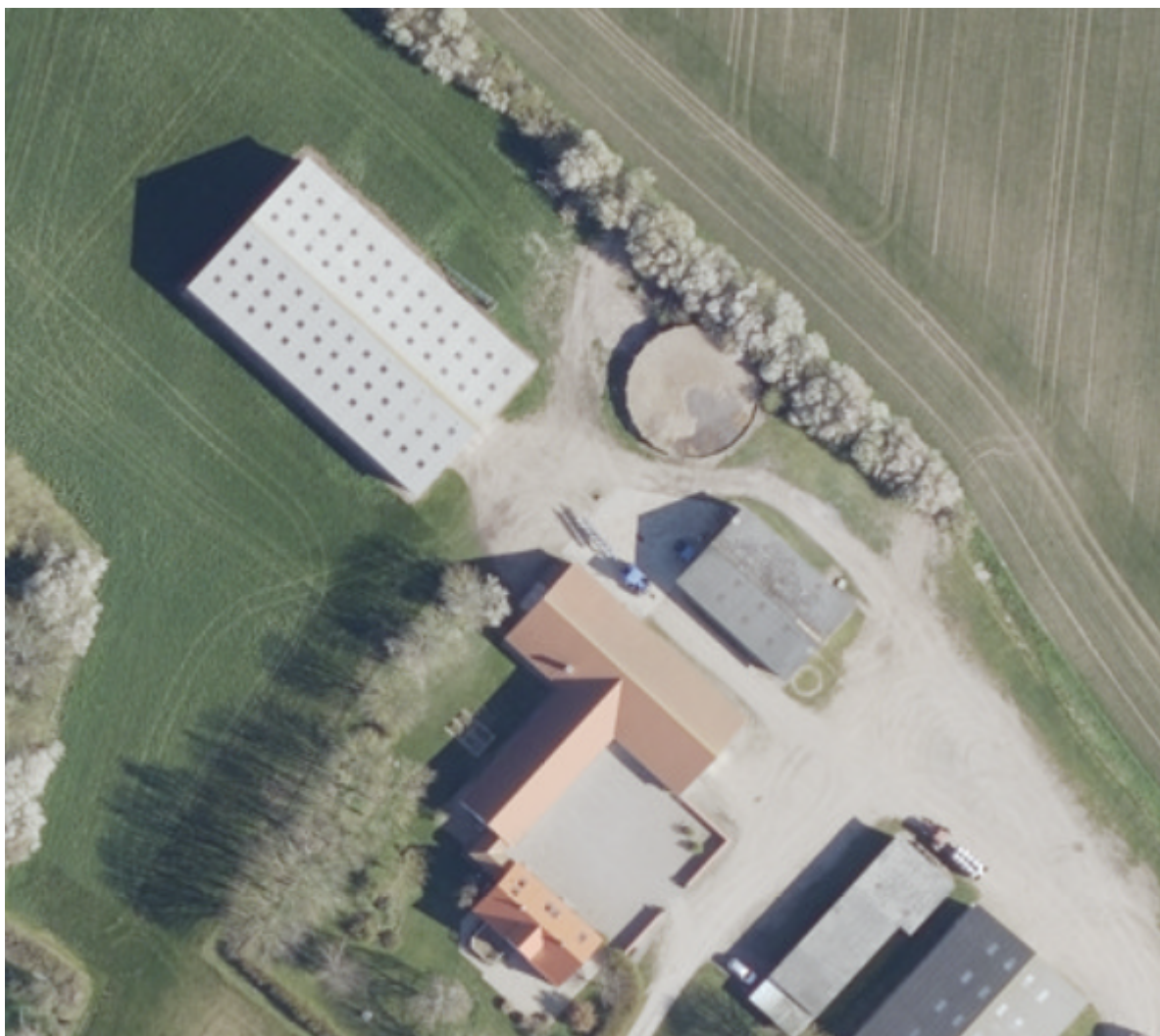
Luftfoto af ejendommens mindste gyllebeholder.
