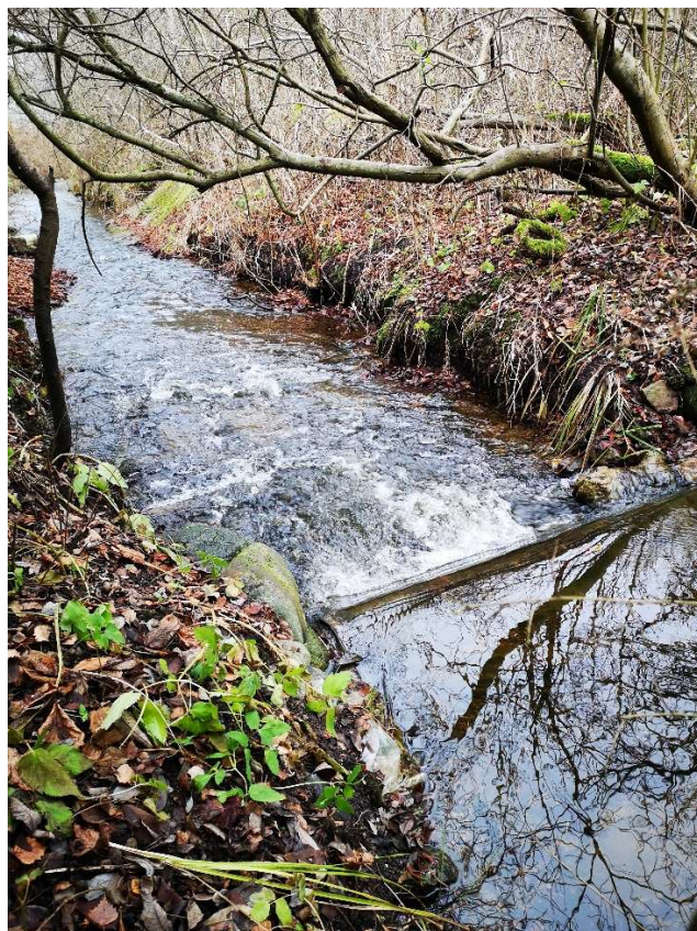
Bregninge Å, tærskel og stejlt stryg, st. 481
