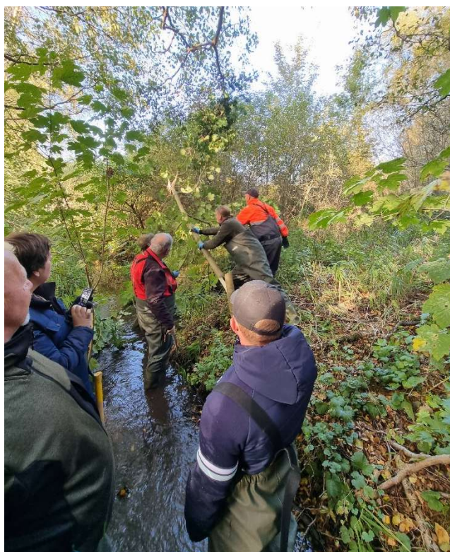
Metode 2, hvor en stamme skæres delvis over. Metode 3, hvor gaffelgrene fastholder "Dødt ved".
