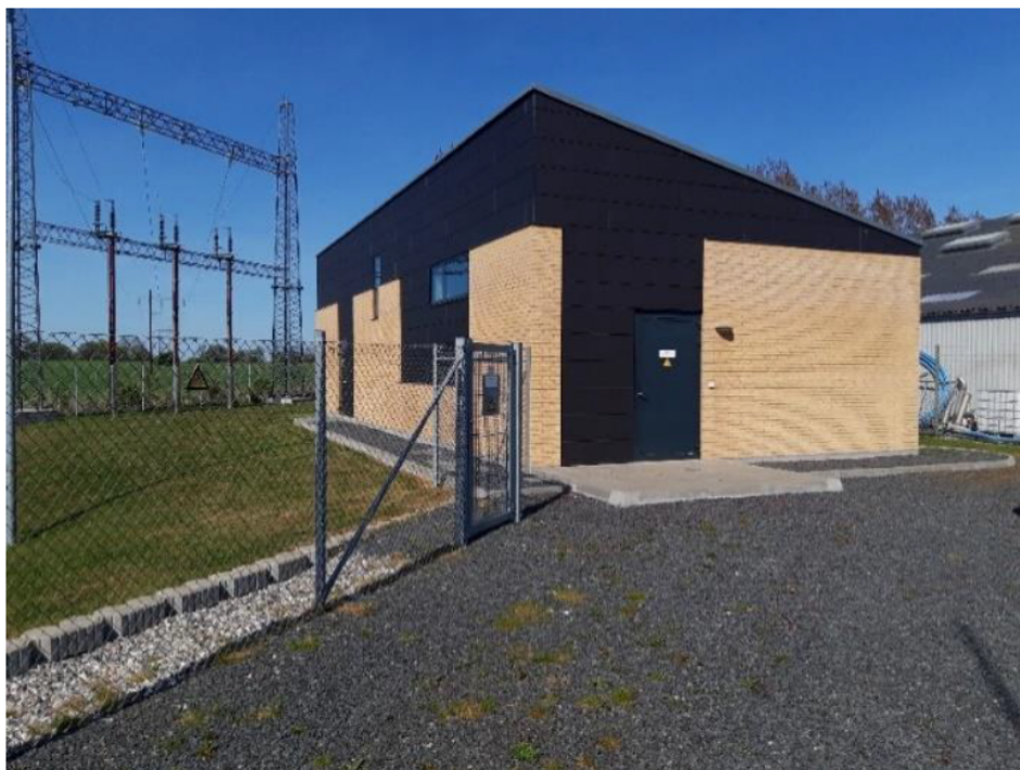
Billede: 2 - Tilsvarende transformerstationsbygning beliggende Ole Borchsvej 4, 4760 Vordingborg.
