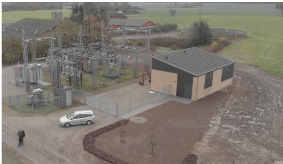
Billede: 1 - Tilsvarende transformerstationsbygning beliggende Palmevængevej 5A, 4250 Fuglebjerg.
