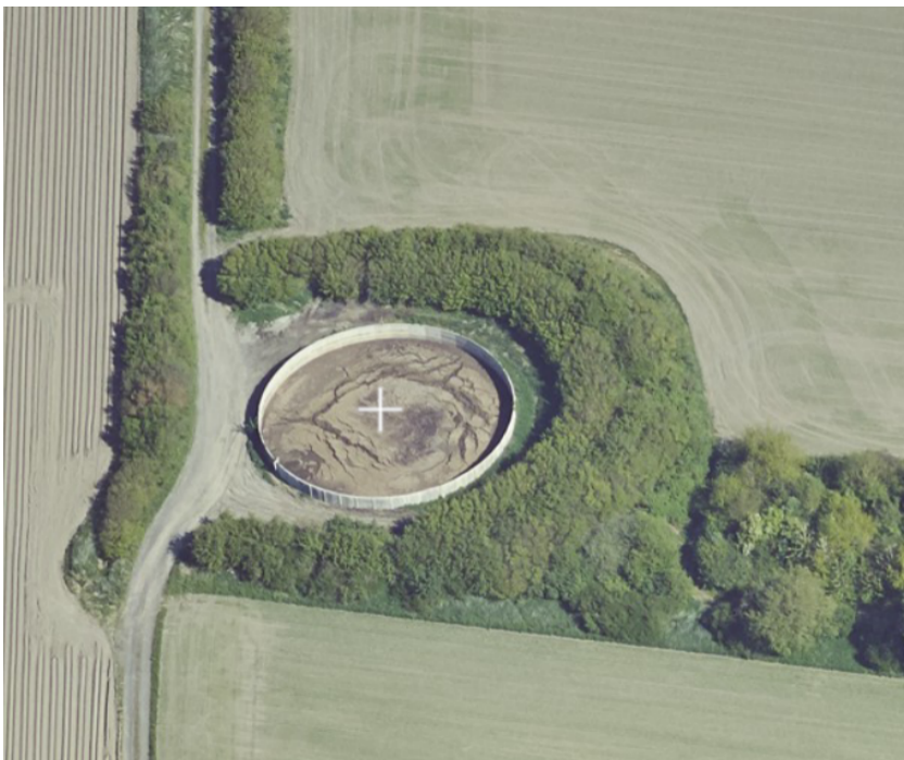
Billede 2. Skråt luftfoto af gyllebeholder
