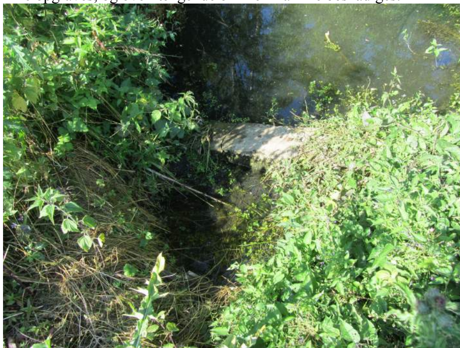
St. 2077 rørelementer skiller.
