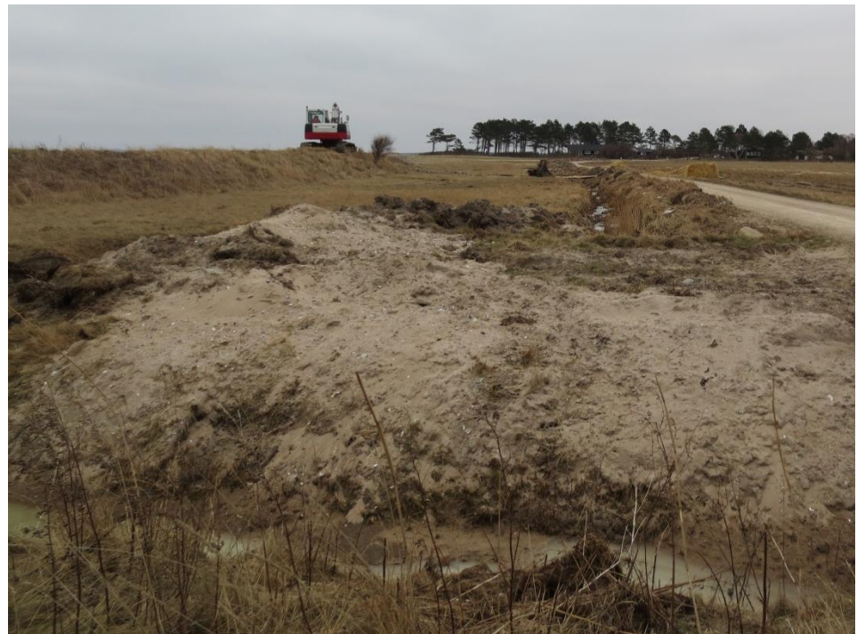
Figur 6.3: Midlertidig afvandingskanal bag dige 3-4. Gravet lige efter Bodil.
