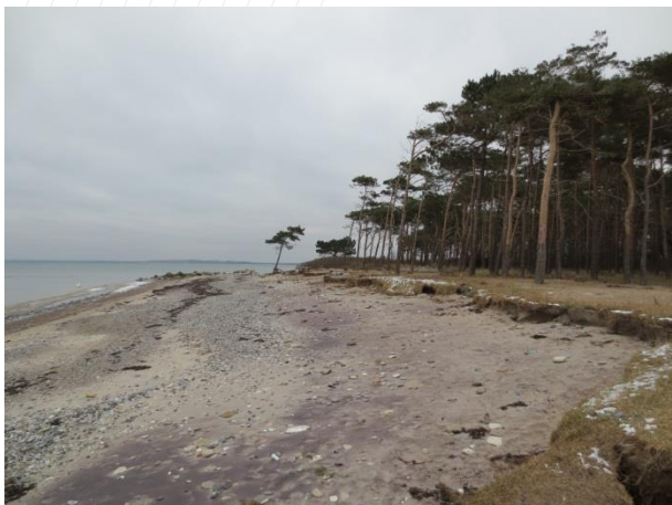
Erosion af digefoden længst mod vest
