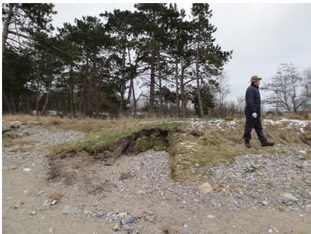
Erosion af digefoden bag bølgebryderne
