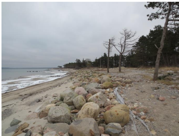
Erosion istensætningen ved den offentlige strand
