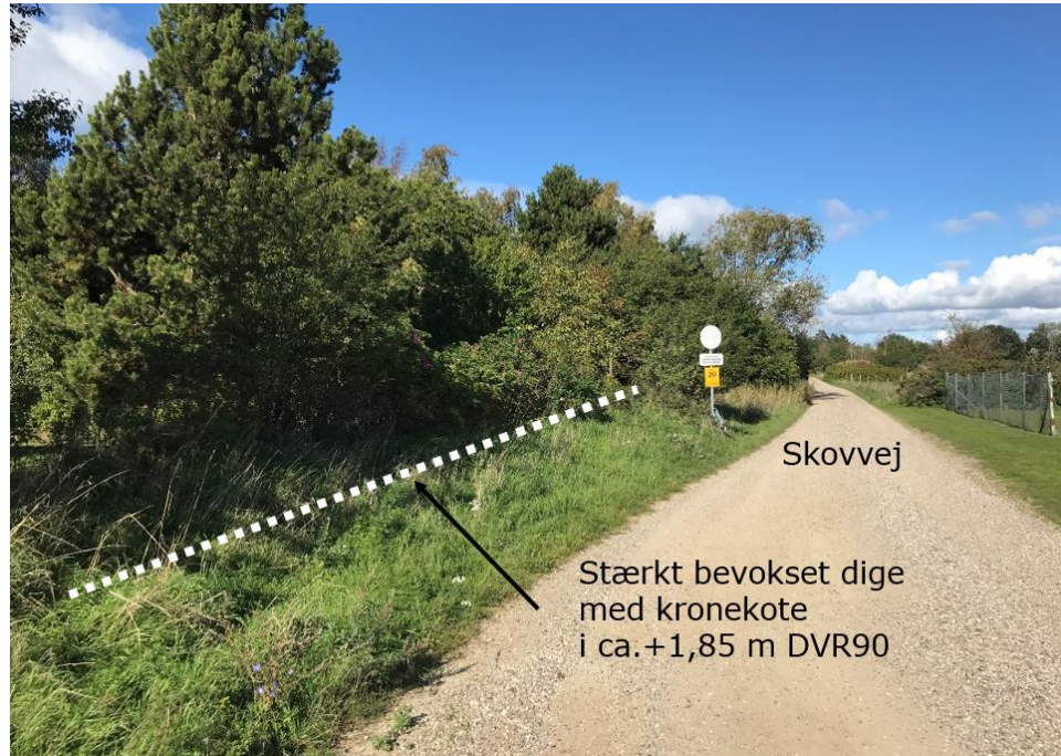
Figur 8.6: Digestrækning 7 langs Skovvej er beskyttet på de først ca. 200 m indtil vejen drejer mod venstre med et dige med topkote i ca. +1,8-+1,9. Diget er stærkt bevokset.
