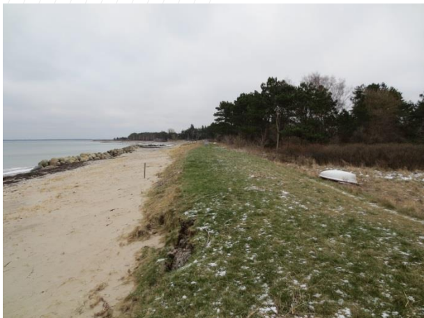
Erosion af digefod bag bølgebryderne
