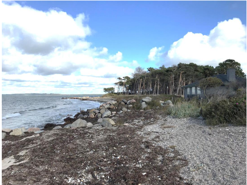
Figur 8.3: Høfde og skråningsbeskyttelse ved Knudsvej 44.
