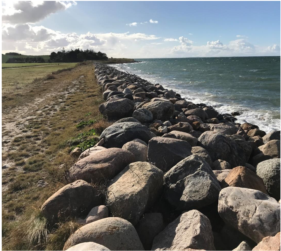
Figur 8.4: Dige/kysbeskyttelse langs digestrækning 3-4.
